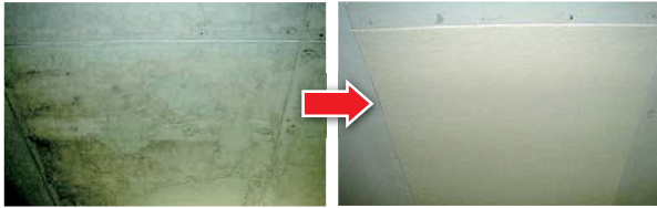
↑ 結露によりカビが発生した天井(左)に調湿性塗料を施工した(右)
