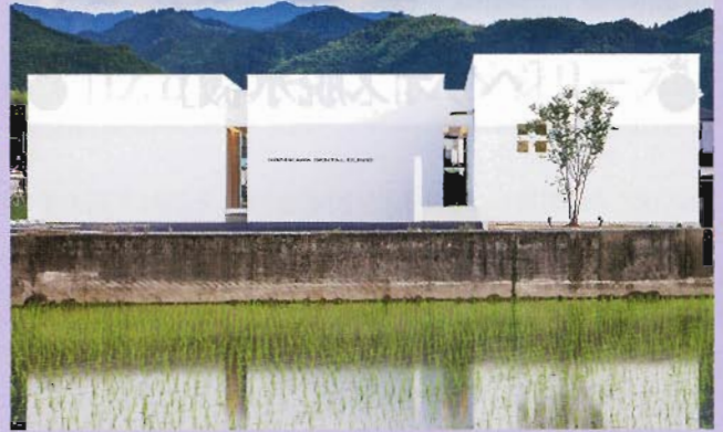
▲外壁用「OPTIMUS WHITE PAINT」の施工例
